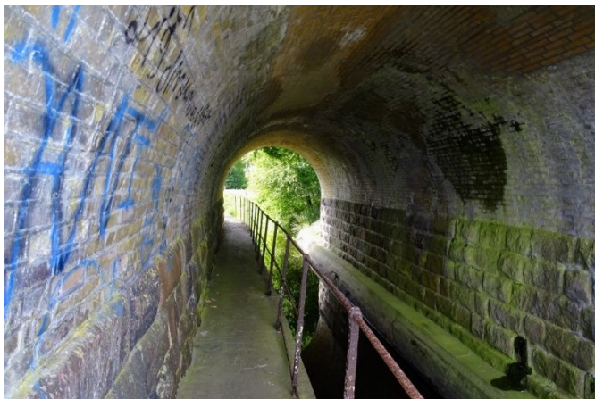
Underføringen under den fredede jernbanebro over Tuel Å, en del af den gamle lukkede kirkesti fra Gulagervej til Slaglille Kirke.
