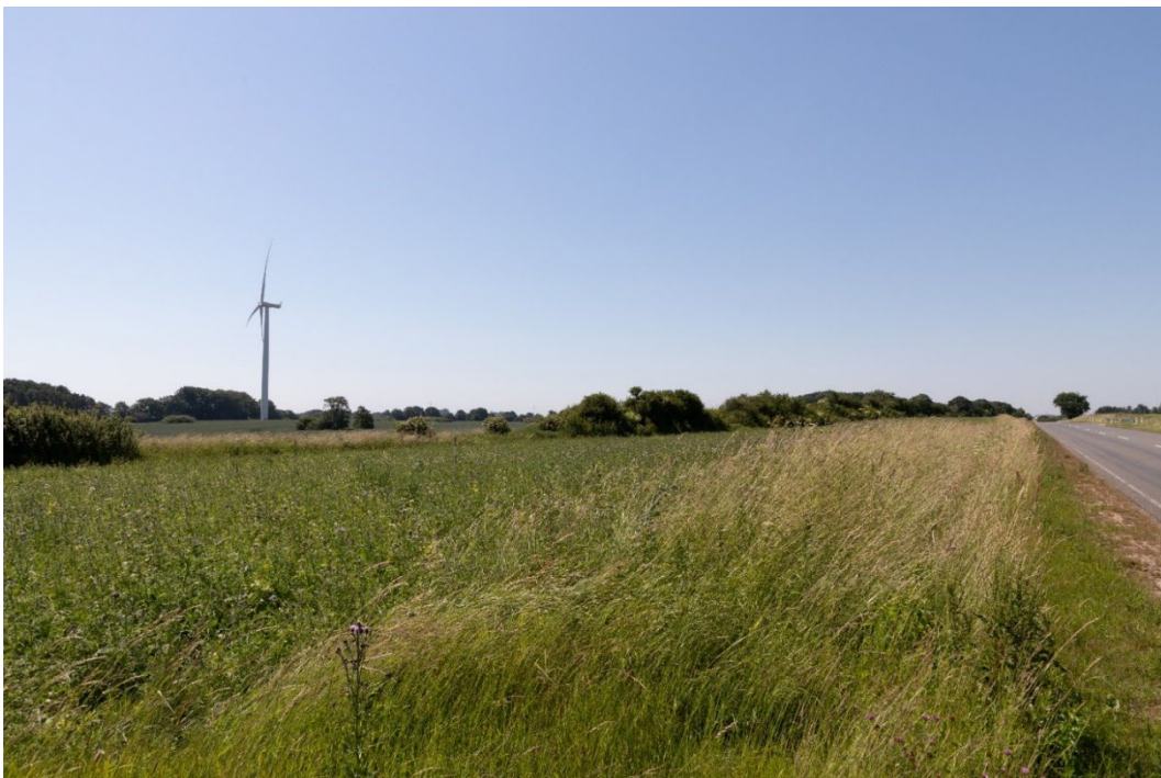
Foto fra landevejen Tjørntvedvej, nordøst for lokalplanområdet, der herfra ligger bag de eksisterende to 126 meter høje vindmøller, hvoraf den ene ses på fotoet.
