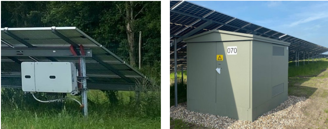
Figur 2 Eksempel på inverter (t.v.) og transformer (t.h.).
