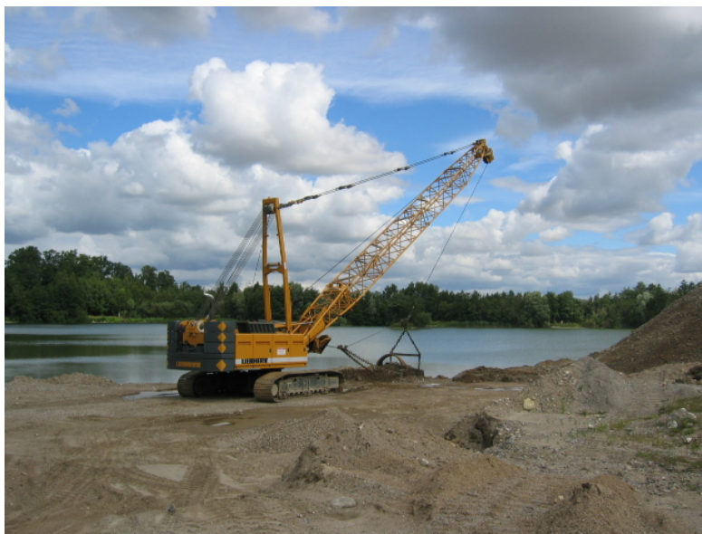
Figur 3.3.18: Indvinding under vand foregår med en wiremaskine.
