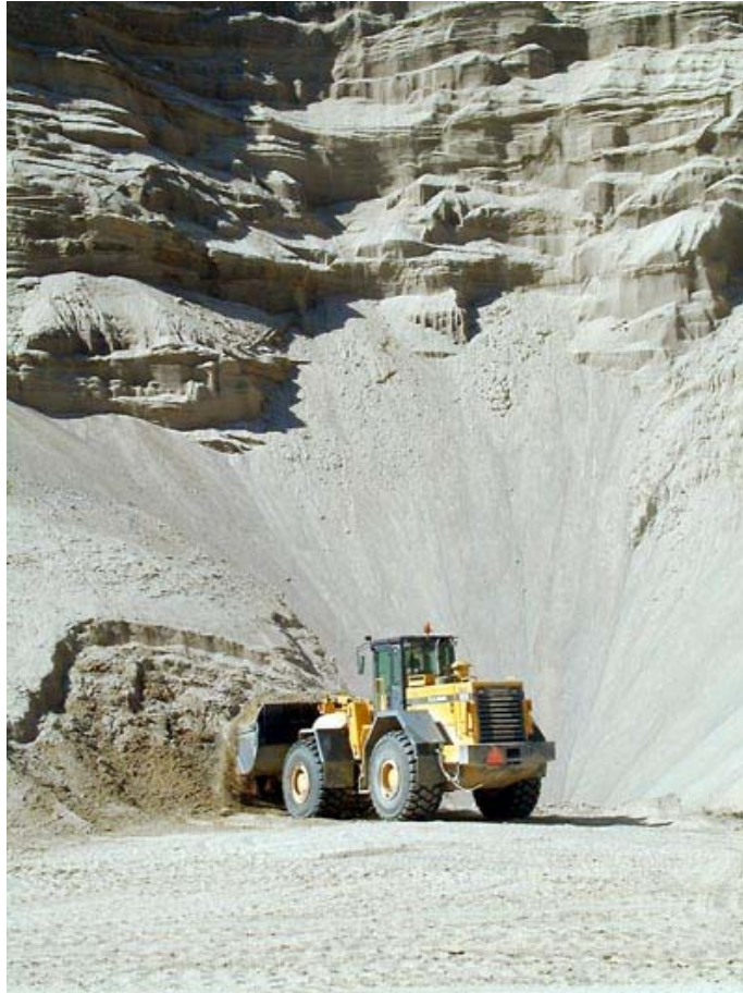
Figur 3.3.19: Gummihjulslæsser – gravning ved gravefront.
