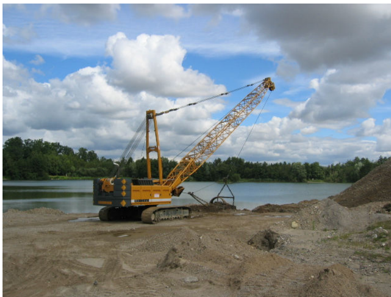
Figur 3.3.18: Indvinding under vand foregår med en wiremaskine.
