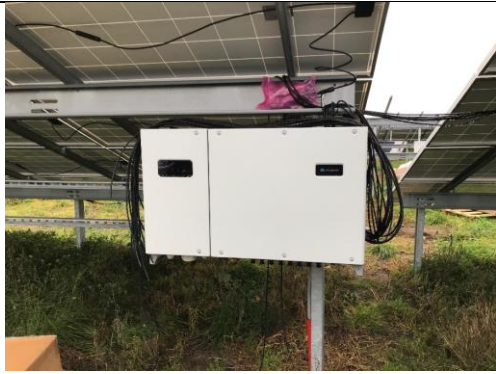
Fig. 9: Eksempel på string-inverter
