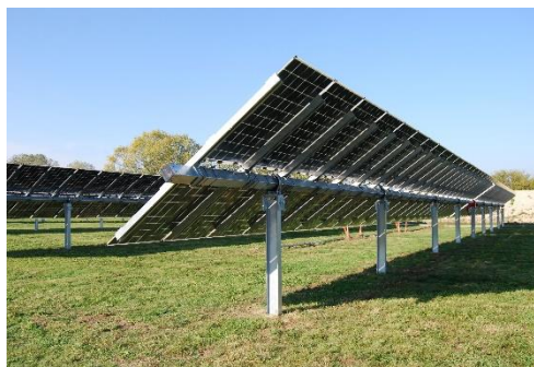
Fig. 2: Eksempel på solpaneler monteret på stativer med tracker-mekanisme.
