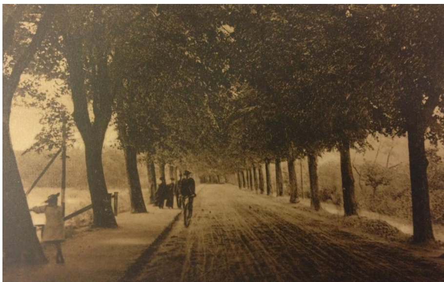
Banevej før omlægning
